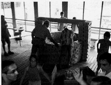
La construction du puits
